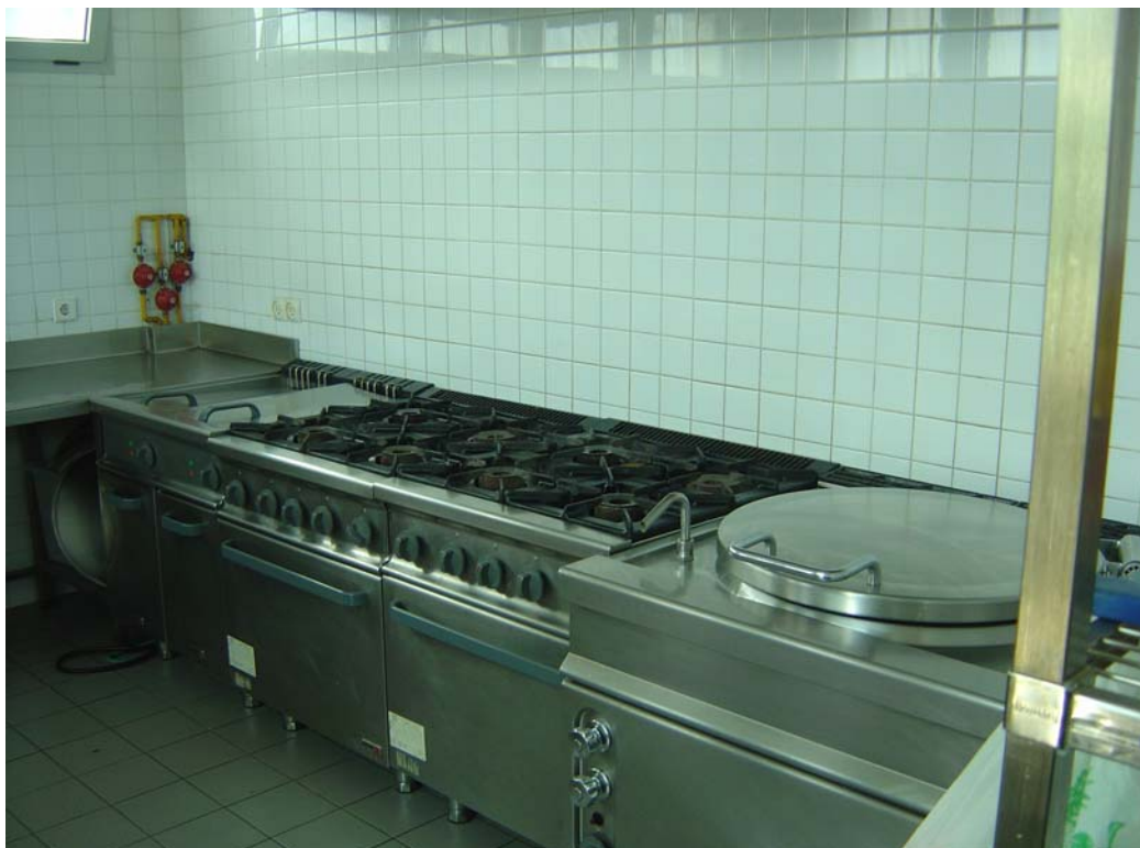
Interior cocina: zona de cocción.
