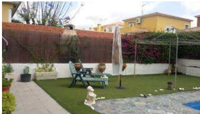
Estado del vallado de la parcela colindante de la calle [REDACTED]
