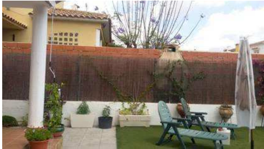
Aspecto del nuevo vallado y barbacoa abierta adosada a la medianera
