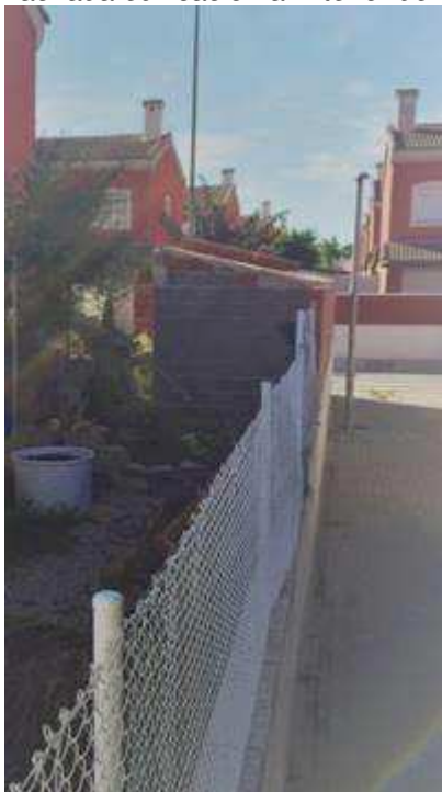
Detalle de la edificación auxiliar
