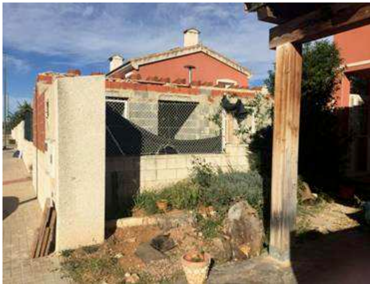
Tramo de la fachada de la edificación auxiliar que recae al interior de la parcela privativa
