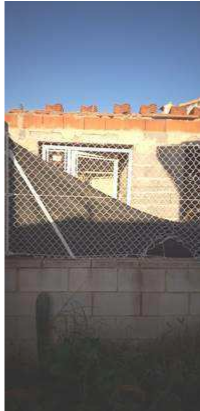
Carpintería de la edificación auxiliar
