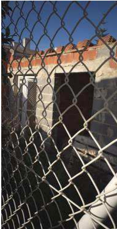
Fachada edificación al interior de la parcela
