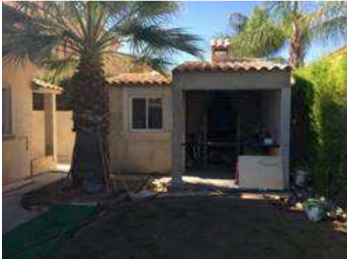
Año 2019. Vista frontal de la edificación auxiliar
