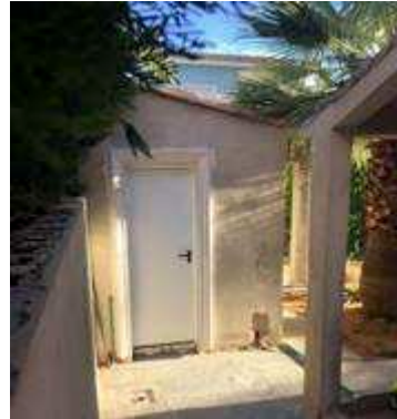
Año 2019. Vista frontal de la edificación auxiliar.
