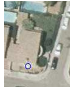
Año 2018. Fecha de vuelo 3/06/2018 a 30/07/2018. Se aprecia formación de cubierta.
